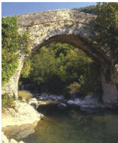
Laurino - il fiume Calore presso il ponte di S. Rocco Laurino - the River Calore at the bridge of San Rocco
